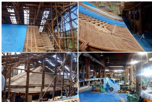
丸太足場は、文化財的な伝統工法として後世に伝えていかねばならない優れた工法である。柔軟性に富みどのような変化にも対応可能であるが、常に品質の良い丸太足場が確保されていなければならないこと、経験十分な技術者が必要なことから、道後温泉本館に採用できる工法ではないと思われる。
