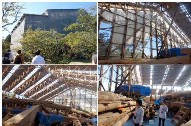
仁和寺の観音堂（重要文化財）保存修理工事は、京都府の伝統的工法である丸太足場で施工されている。府の中に30年の経験と実績を持つ専門家が配属されており、施工業者も専門業者の分離発注されている。構造計算ができないため、材料品質と実務経験に頼らざるを得ない工法である。
