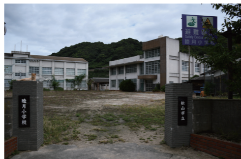
集落中心の睦月小学校跡地 (2020.9 撮影)
