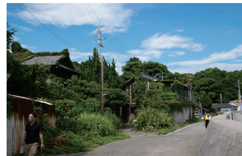
植物が繁茂する廃屋 (集落中央部) (2020.8 撮影)
