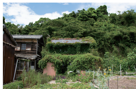
植物に侵食される廃屋群 (2020.8 撮影)
