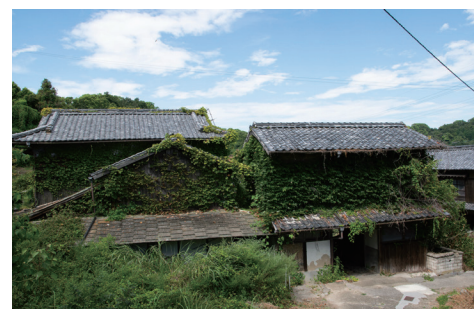
植物に侵食される廃屋群 (2020.8 撮影)
